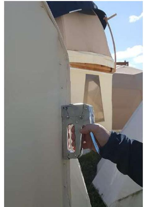
Mise en place des baguettes de finition au niveau du sas. Attention il faut pré-percer les baguettes.
