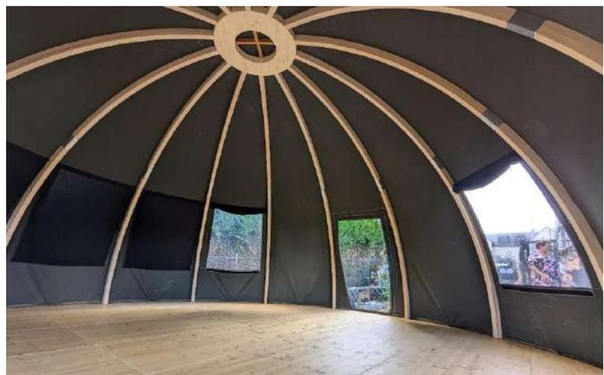
B.O.B est une tente démontable de forme demi-sphérique, composée d'une ossature bois et d'une toile extérieure. Cette tente peut être installée à même le sol, sur un plancher rond ou sur une terrasse bois.
