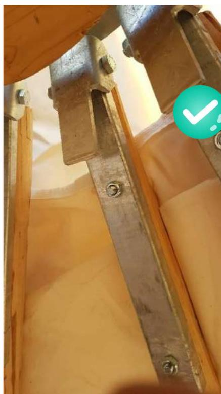
**Attention** : ne pas monter trop haut le pied de levage. Les perches ne doivent pas aller au-delà du diamètre car il est difficile de redescendre l'ensemble. Les perches se bloquent. Il est possible que les perches ne soient pas centrées par rapport au plancher. Dans ce cas, terminer le montage en soulevant le bas des perches du côté où elles sont éloignées du plancher.
